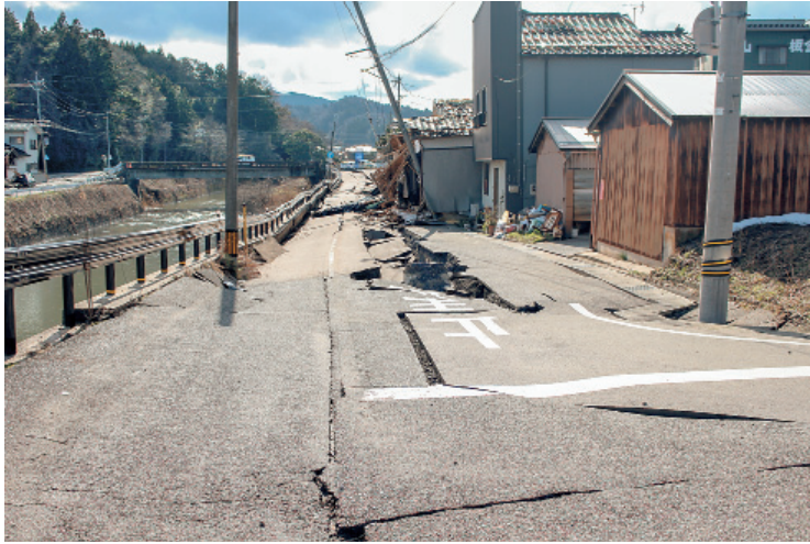
震災1カ月後の輪島市内。石川県保険医協会提供
