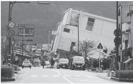
輪島市街地ではいたるところで家屋が倒壊していた
