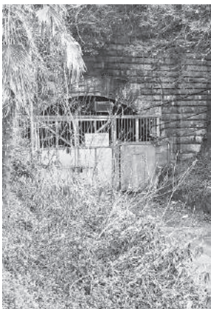
旧生駒トンネル。柵でふさがれて立ち入り禁止になっている
