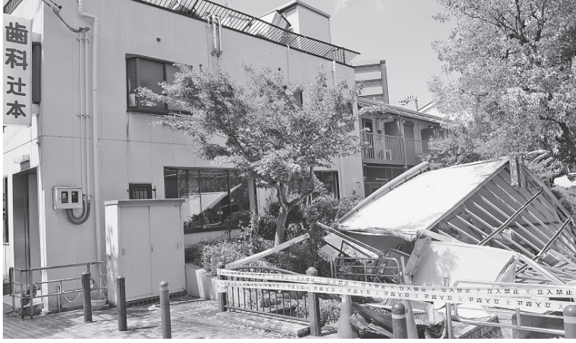
強風によって屋上から転落した物置（大阪市城東区・辻本歯科）
