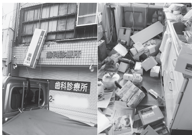
右:棚の上の歯科材料は落下し、散乱した(写真提供:同上) 左:茨木市内の診療所では外壁が広範囲にわたってはがれ、看板が外れた(画像を一部加工しています)
