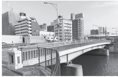
道頓堀川にかかる汐見橋
