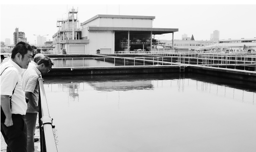
橋下大阪市長が廃止を表明した柴島浄水場
