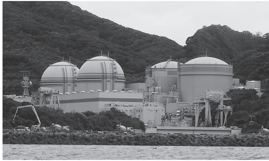
防潮堤の工事が始まった大飯原発1～4号機
