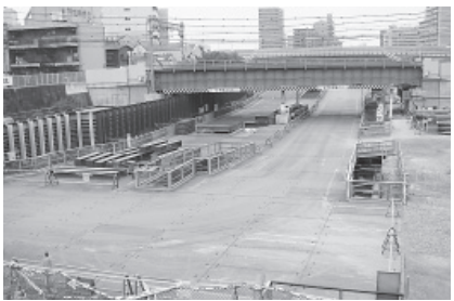
6分短縮のために3000億円超を投じる淀川左岸線工事(福島区)
